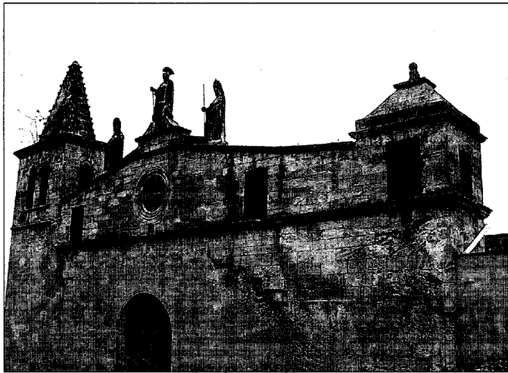
Las grietas y goteras recorren la parte externa del convent de Sant Vicenç. ■ Foto: C. VENY
